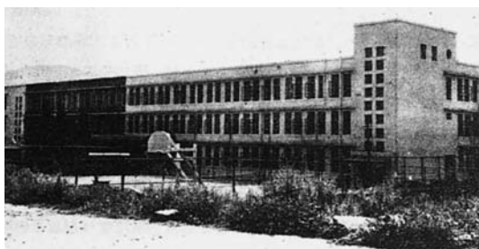
修理中の昭和町校舎 (昭和28年)
